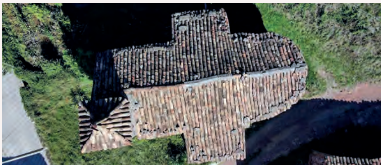
Sant Esteve de Ventolà.
